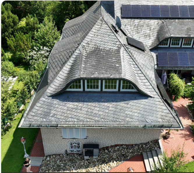
Schieferdeckung & Anschlüsse im Detail
