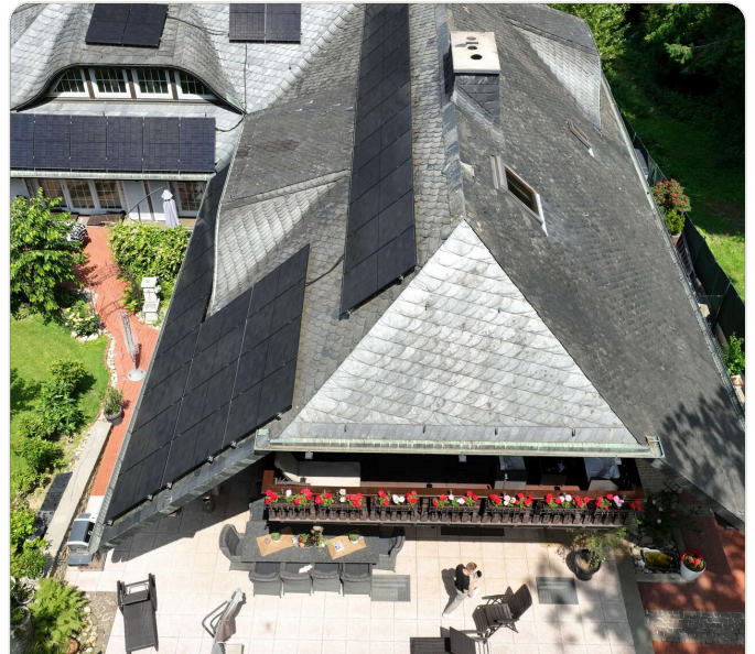
Terrassenseite mit PV-Feldern
